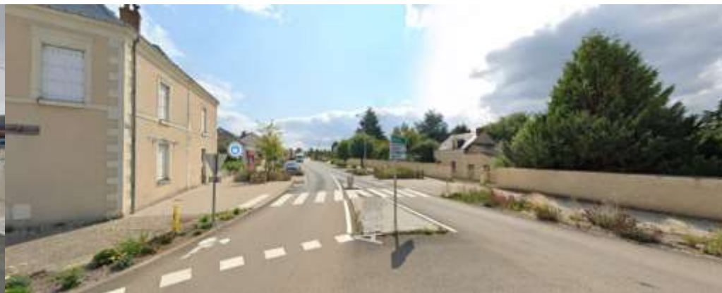
- Réaménagement de l'avenue d'Angers ponctuée de commerces
