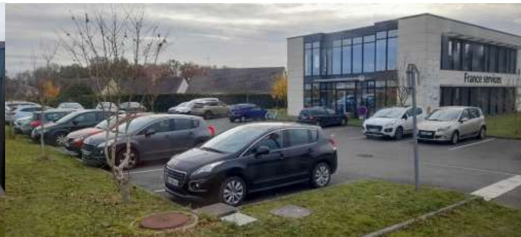
Maison France service à l'entrée de la ZI et du bourg
